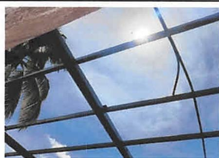
Foto 6: Instalación de cubierta de lamina (instalación y pintado de costaneras e instalación de lamina nueva).
