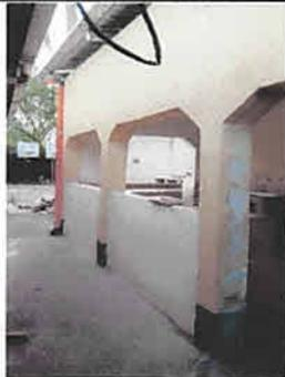
Foto 5: Remozamiento de pared (demolición y suministro e instalación de pared de block).
